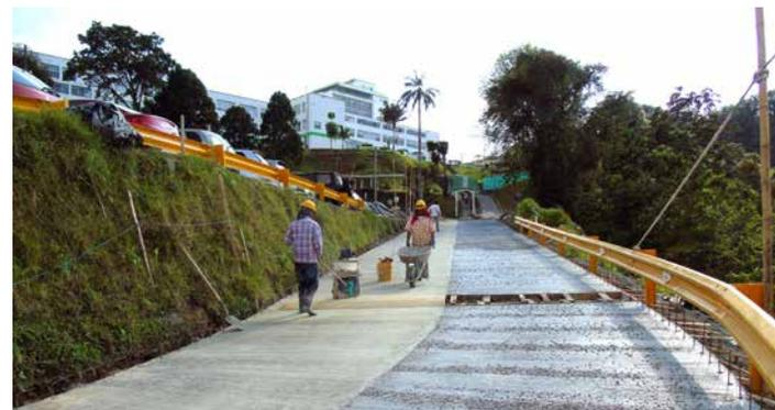
*Construcción de vía posterior, conformación de taludes, y manejo de aguas lluvias.*
